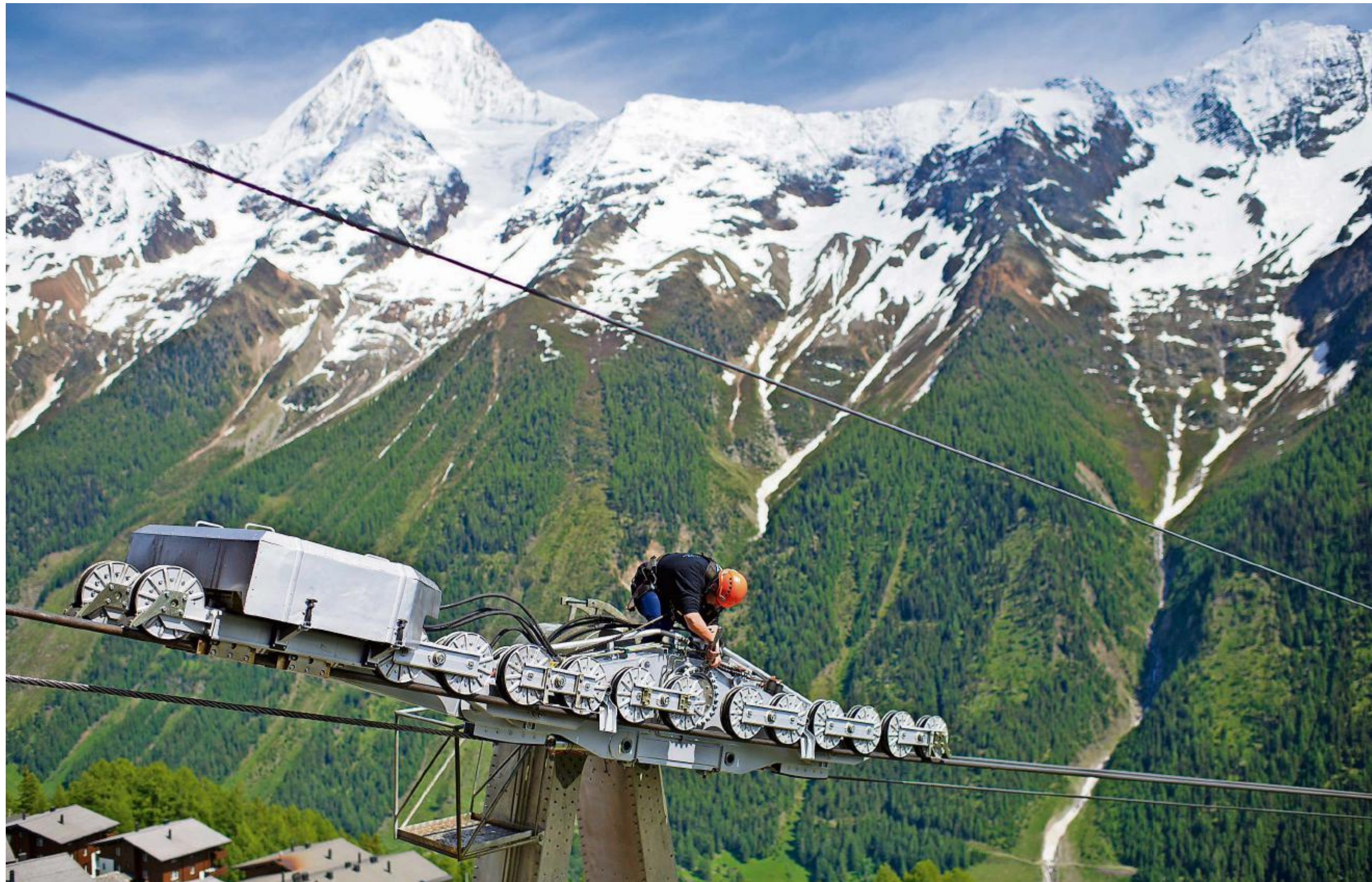
Schwachpunkte ausmerzen: Ein angehender Seilbahn-Mechatroniker wartet die Laucheralp-Bahn in Wiler bei Goppenstein.
